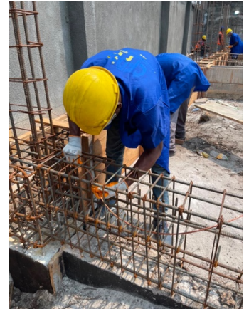
Ausbildung auf der Baustelle
